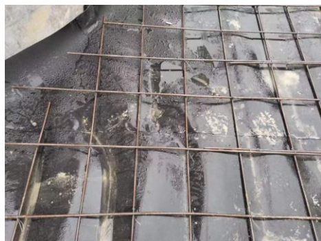
罐区地面防渗（施工期间）
