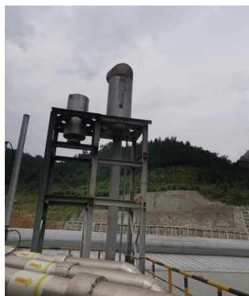
合成氨装置二氧化碳消声器
