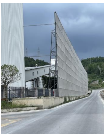
磷矿堆场围挡
