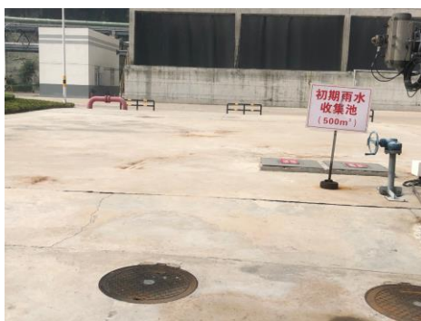
合成氨装置500 m 3 初期雨水收集池
