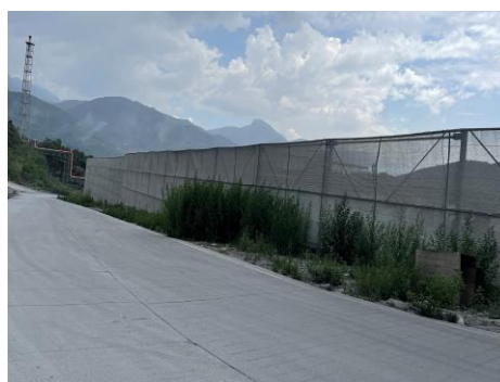
磷矿堆场围挡
