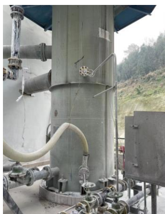
氟硅酸钠干燥废气水洗塔
