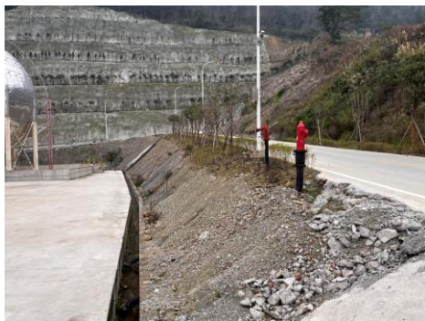
液氨储罐区消防栓消防水炮
