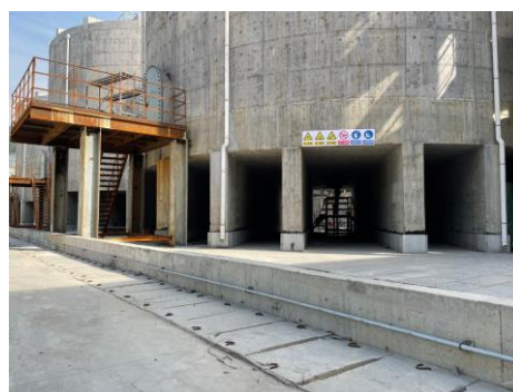
磷酸氟硅酸罐区围堰3200m 3
