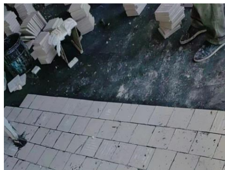
危废间地面防渗（施工期间）
