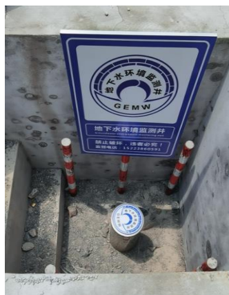
厂区内地下水监测井2
