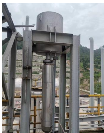
合成氨装置蒸汽消声器
