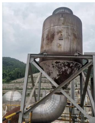
合成氨装置蒸汽消声器
