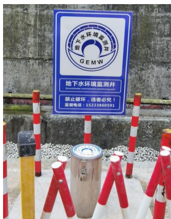
厂区内地下水监测井1
