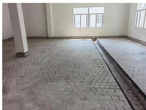
危废间收集沟
