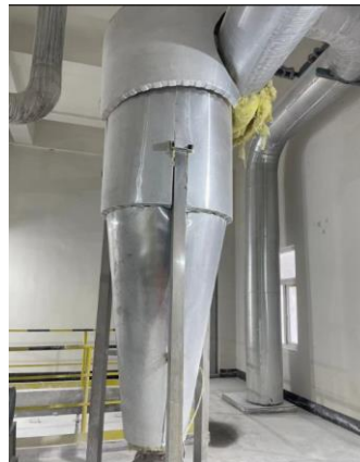
氟硅酸钠干燥废气旋风
